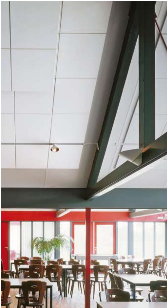
Alternatieve oplossing met een verlijmd plafond
